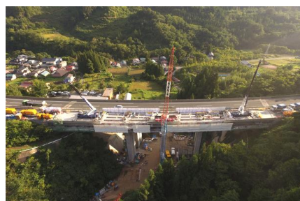
更新工事の様子
