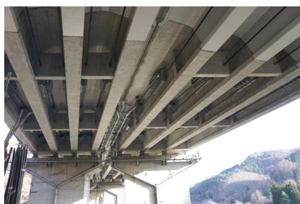
工事完了(下面)
