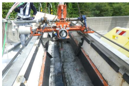
NSRV工法による桁端部の修繕
