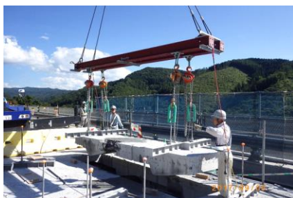
床版コンクリートの撤去
