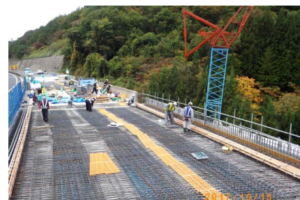
更新部分の鉄筋組立
