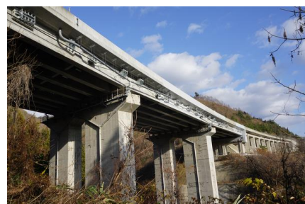
工事完了(側面)
