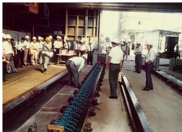
型枠設置前の確認
