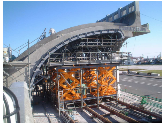
天蓋の移動型枠装置
