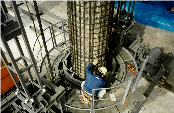
鉛直鉄筋の周囲にPC鋼材を巻き付け
