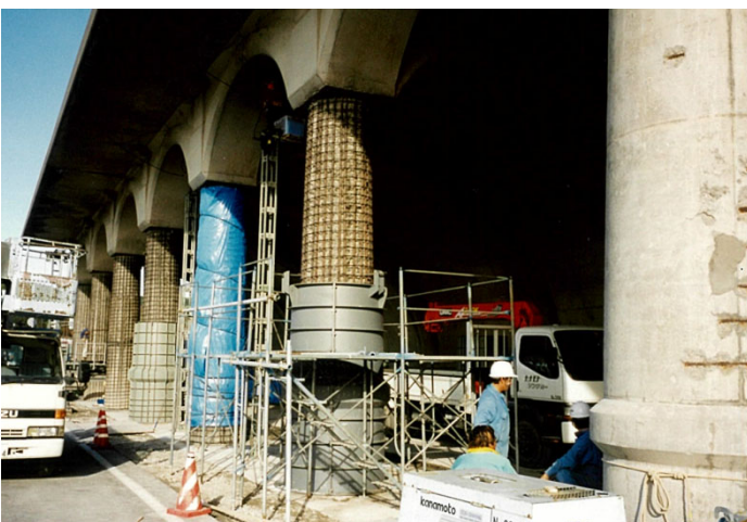
柱の型枠の設置
